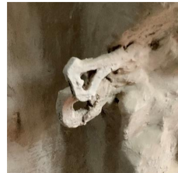
Schlossfalle: Putz entfernen
