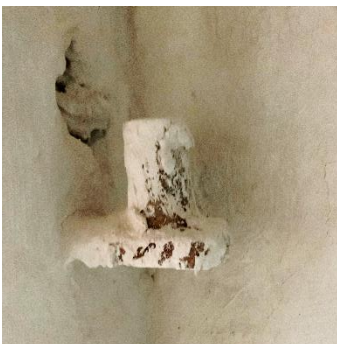
Obere Türangel: Putz entfernen (Funktion wiederherstellen)
