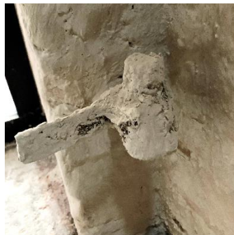
Untere Türangel: Putz entfernen Überrest Langband abnehmen (Funktion wiederherstellen)
